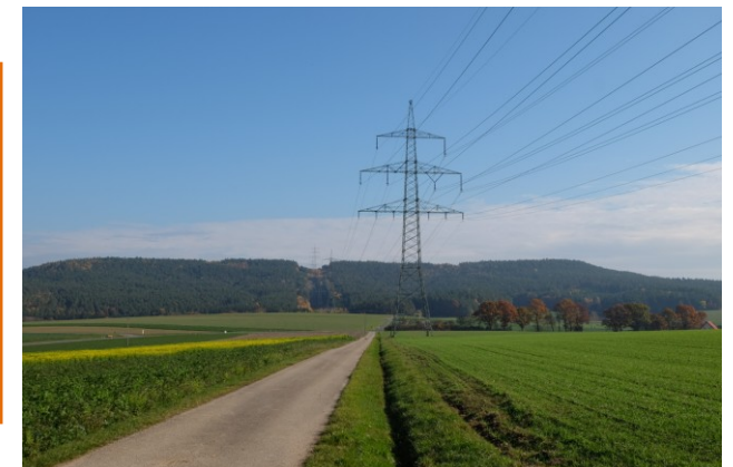
Blick Richtung Ebnetz mit dem Ostbayernring
