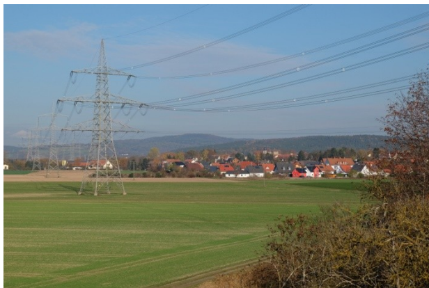
Blick auf Redwitz mit Masten durch das Steinachtal
